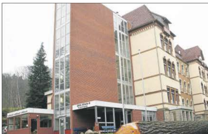
Das Hauptgebäude der DRK-Klinik Kaufungen: Das weitläufige Klinikgelände böte noch Platz für Erweiterungen. So arbeitet man derzeit an einem Konzept für eine Komplexeinrichtung mit pflegendem und betreutem Wohnen, Tagespflege und ambulant betreuten Wohngruppen. Archivfoto: Stier
