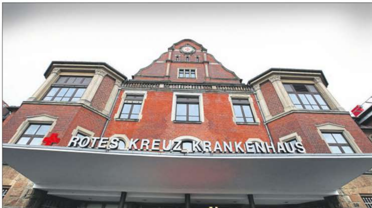
Eindrucksvolles Gebäude: Am Standort Krankenhauses an der Hansteinstraße in Wehlheiden ist es in den vergangenen Jahren durch stetige Erweiterungen eng geworden. Die Klinikhehe bietet neue Möglichkeiten, zu wachsen. Archivfoto: Fischer
